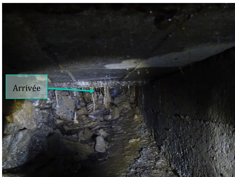
Illustration 13 : Cliché de l'intérieur du captage de « Coume Arrau Biac Rive G » - Arrivée de la source
