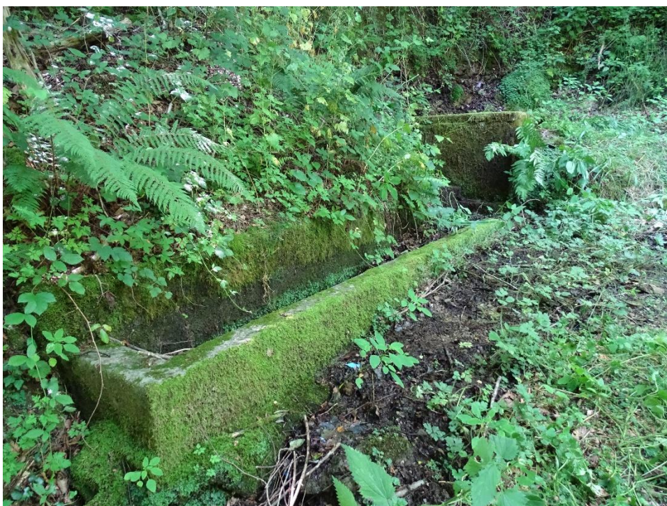
Illustration 22 : Ancien lavoir accolé au captage
