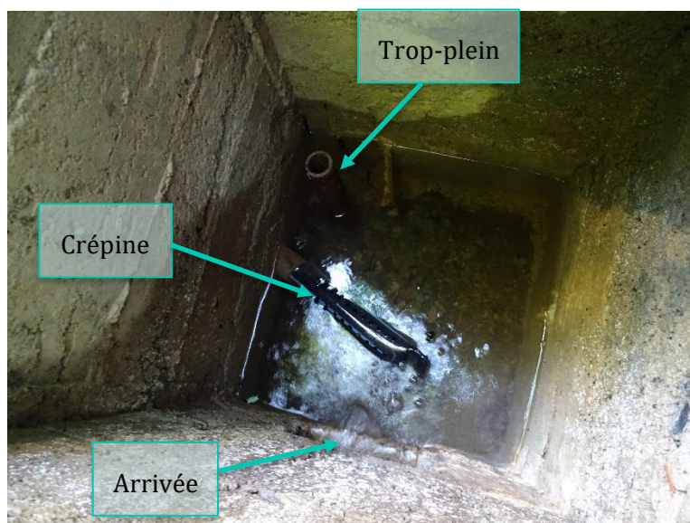
Illustration 14 : Clichés de l'intérieur du captage de « Coume Arrau Biac Rive G »
