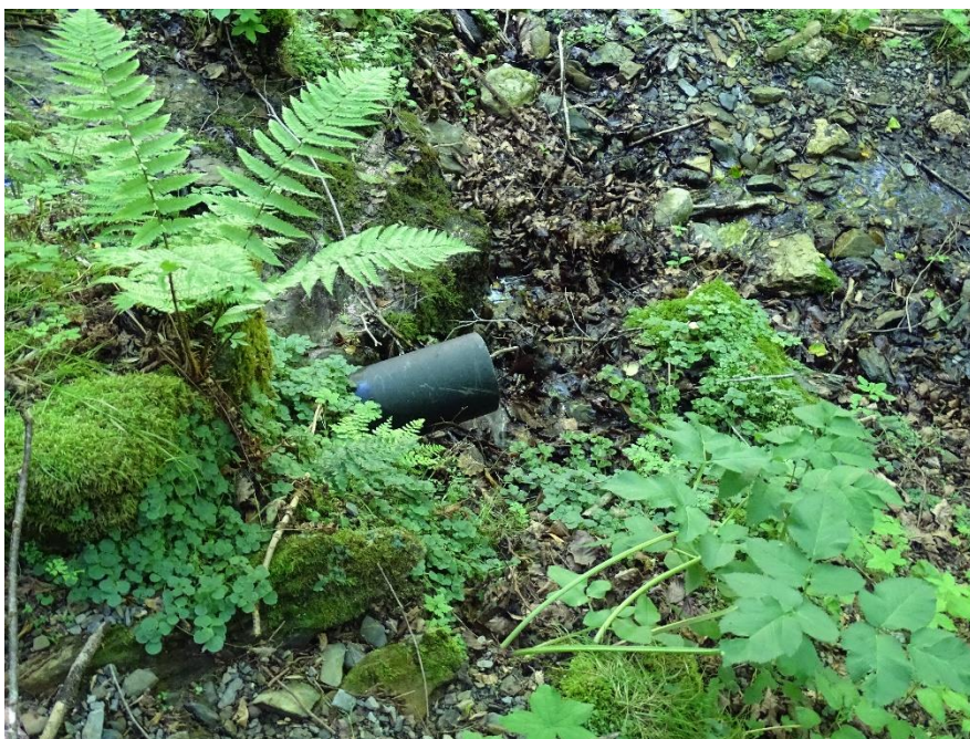
Illustration 11 : Cliché du trop-plein en aval du captage
