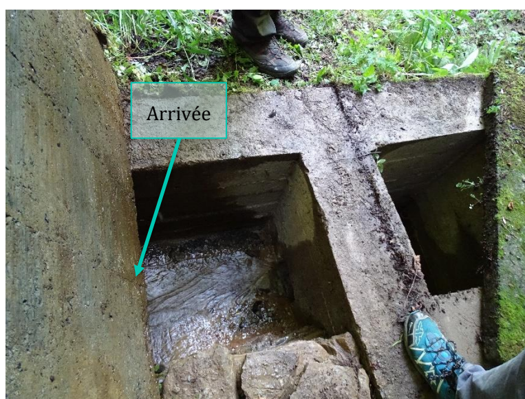
Illustration 13 : Cliché de l'intérieur du captage de « Coume Arrau Biac Rive G » - Arrivée de la source
